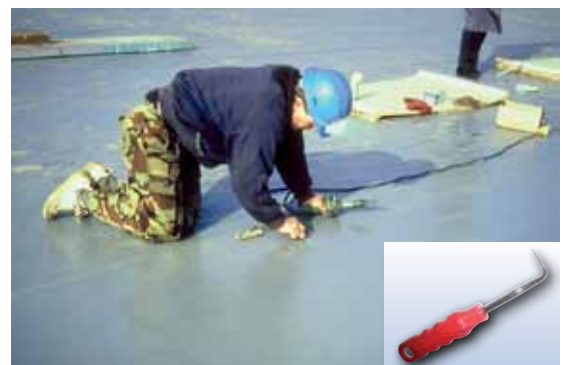
Fig. 2: Kontroll av skarvsvetsning
